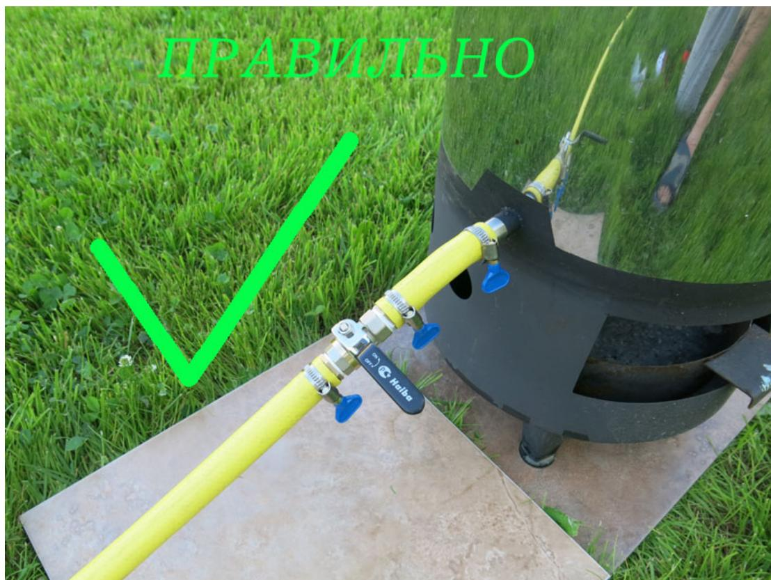
Для тех, кто не знает как поставить кран, следующее фото: нужны 2 штуцера 20 мм, 1/2 дюйма, 1 кранник 1/2 дюйма, три хомута, а так же катушка фоторопластовой сантехнической ленты.
